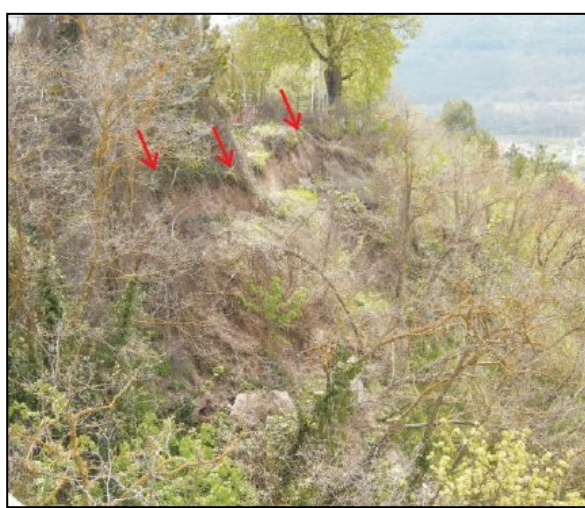
TERREMOTO AQUILA 2009 - emerso
