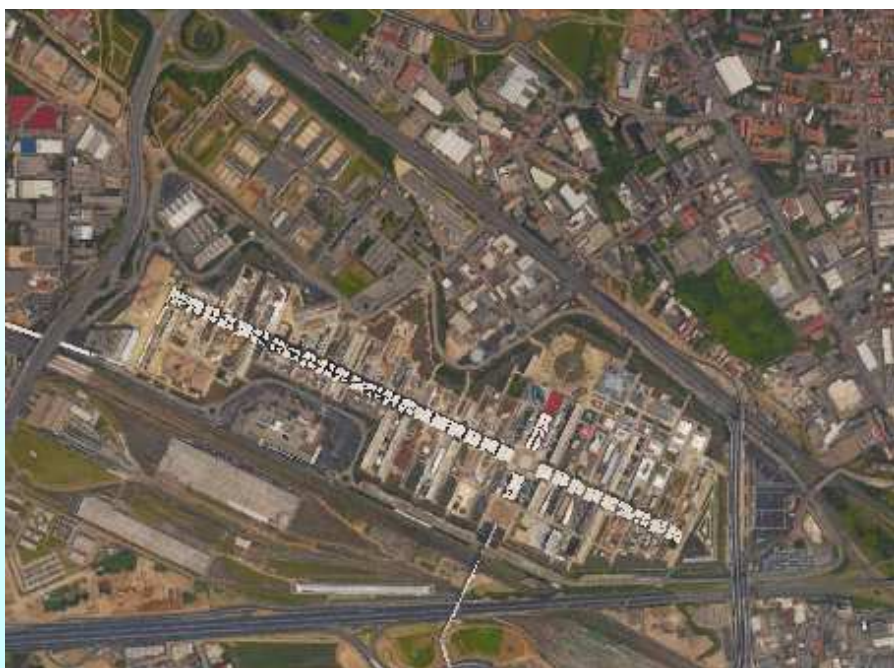
Area EXPO a fine lavori
