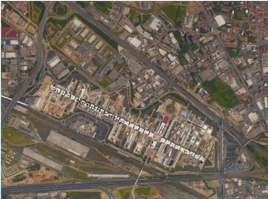
Area EXPO a fine lavori
