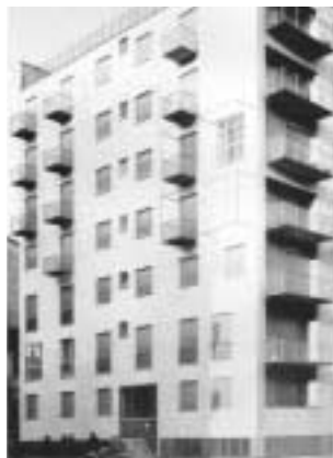
Mario Asnago, Claudio Vender, edificio per abitazioni, via Faruffini 6, Milano. Fronte principale, foto d'epoca.
